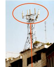
Antenne a pannello per stazioni radio base GSM
