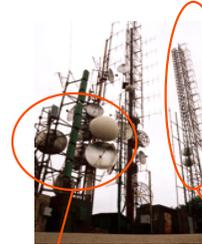
Antenne a riflettore parabolico per collegamento in ponte radio
